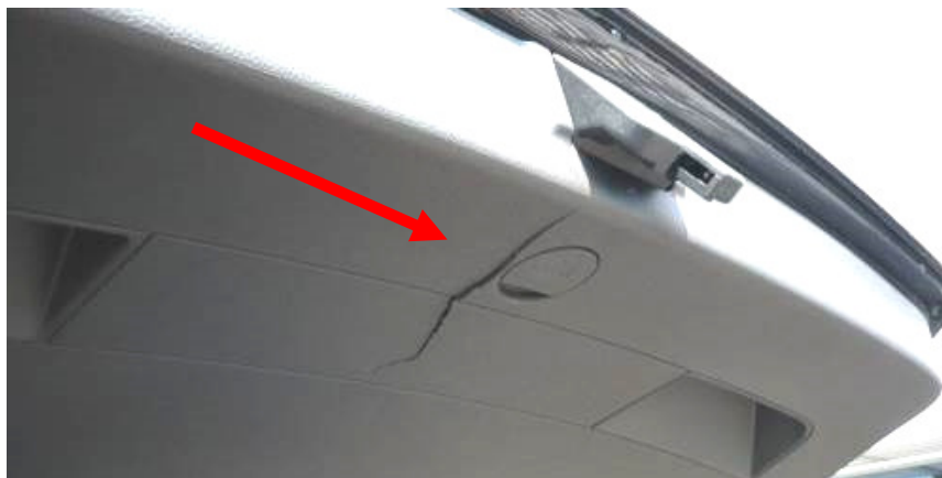
Csomagtér belső sérülései / Damages in the trunk space.
